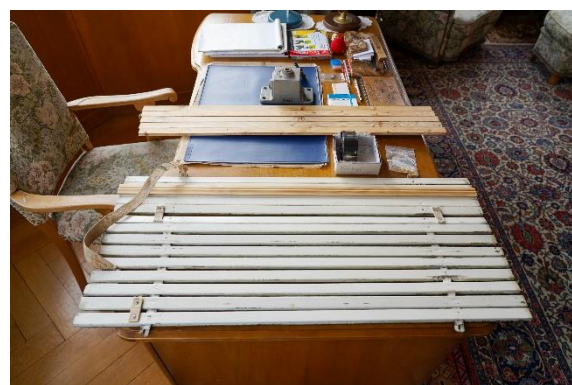
Der ursprüngliche Rollladen
